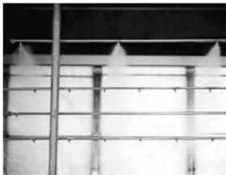
그림3. 수분무시스템 사례 및 개념
