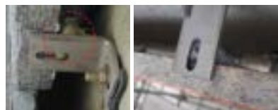
b) 에폭시를 이용한 석재 접착 그림 1. 석재 마감
